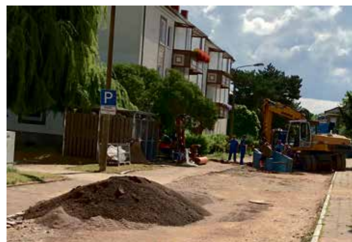
Straßenbaumaßnahme Max-Planck-Straße Bleicherode
