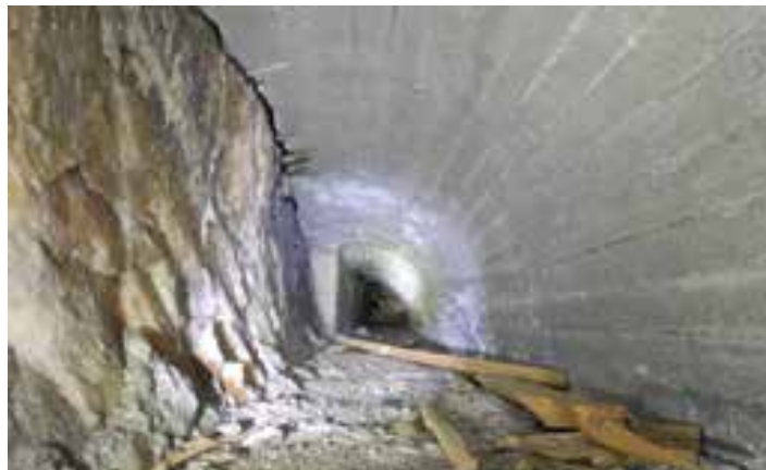
Stahlbetonausbau im Bereich der Muna-Kammern ohne erkennbare Schä- den nach einer Standzeit von nahezu 80 Jahren.
