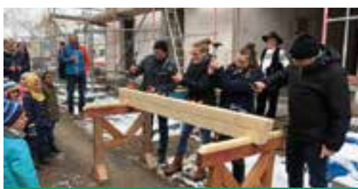
Tagespflegeneubau in Bleicherode
