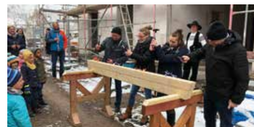
Tagespflegeneubau in Bleicherode
