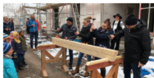
Tagespflegeneubau in Bleicherode
