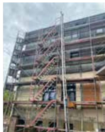
Fassadensanierung Kulturhaus Bleicherode
