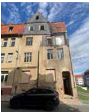
Abbruch des Gebäudes in der Freiheitsstraße 13, Bleicherode
