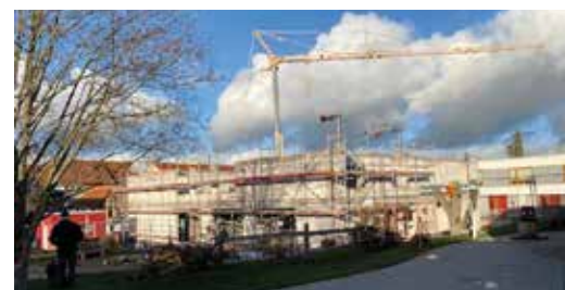
Tagespflegeneubau in Bleicherode
