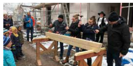
Tagespflegeneubau in Bleicherode
