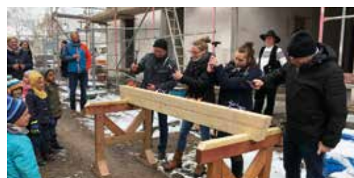
Tagespflegeneubau in Bleicherode
