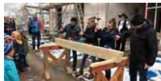
Tagespflegeneubau in Bleicherode
