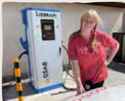
Auch für unsere Kollegin Franziska ist der Umgang an der Ladesäule mittlerweile Routine.
