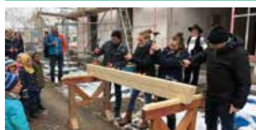
Tagespflegeneubau in Bleicherode
