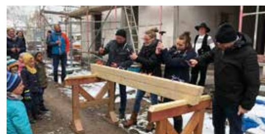
Tagespflegeneubau in Bleicherode
