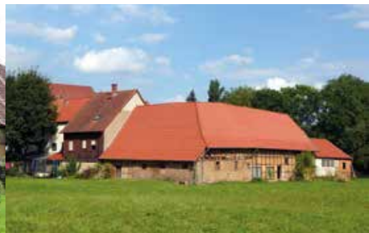
Die sanierten Gebäude, 2023
