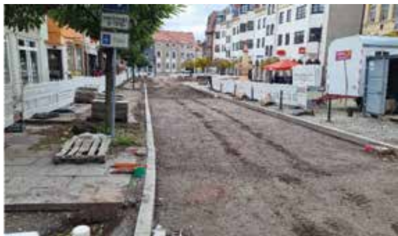
Baumaßnahme Umgestaltung Zierbrunnenplatz
