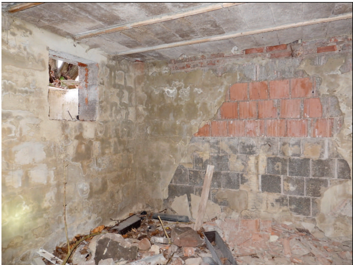
Kellerraum im größten der drei Rohbauten, 09.02.2023, Foto Bellstedt
