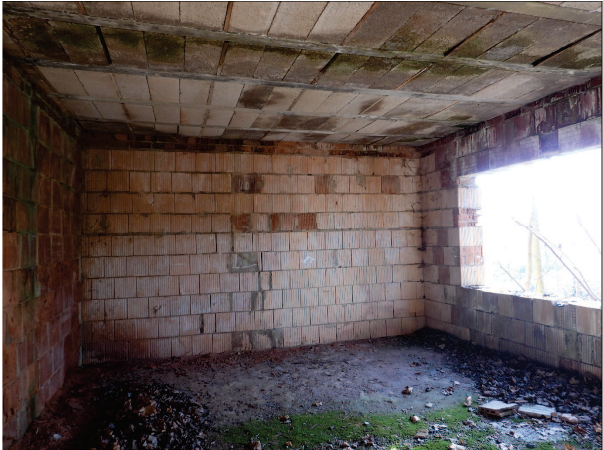
Wohnraum im größten der drei Rohbauten, 09.02.2023, Foto Bellstedt
