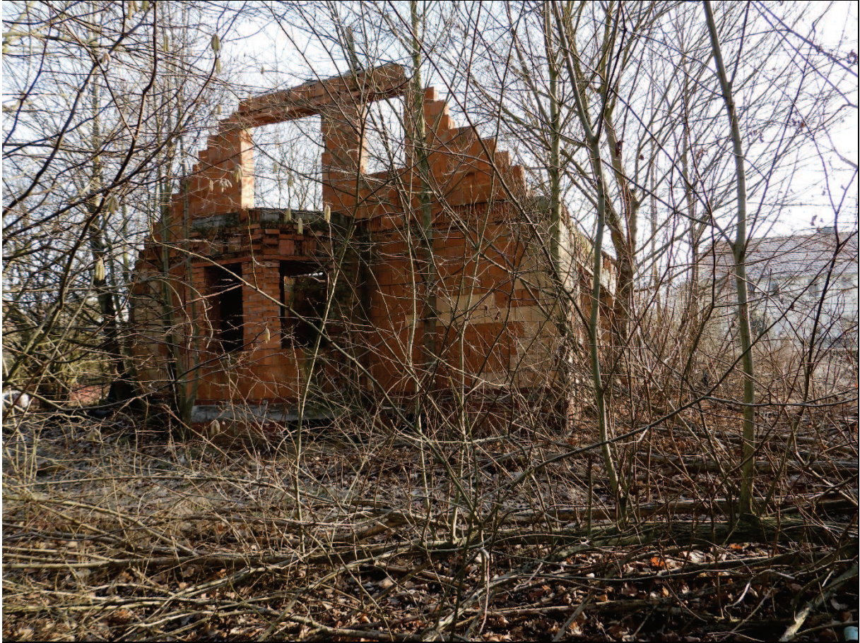
Rohbau der größten Ruine (ohne Dach) am 09.02.2023, Foto Bellstedt
