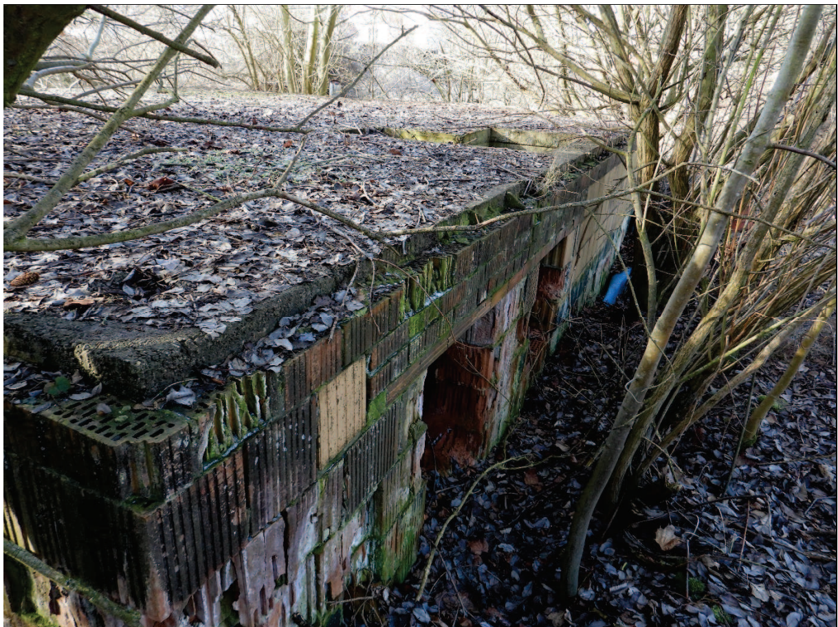
Kellergeschoss einer Bau ruine am 09.02.2023, Foto Bellstedt
