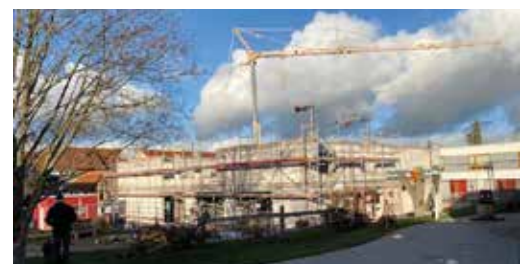
Tagespflegeneubau in Bleicherode
