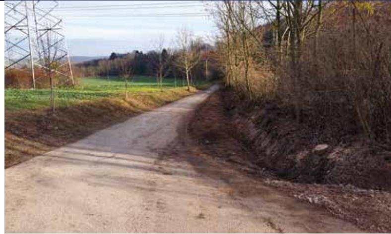
Grabensanierung Zufahrt Tauber
