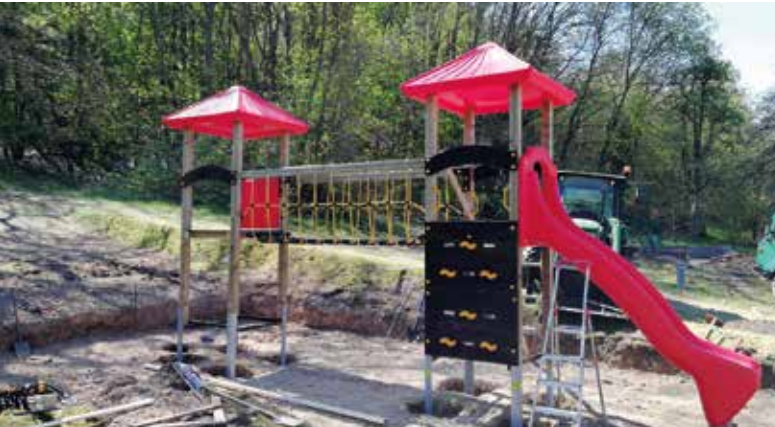
Bauphase Spielplatz - Kletterturm
