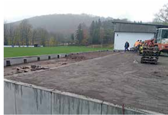
Der Abschluss der Arbeiten ist für Ende November geplant.
